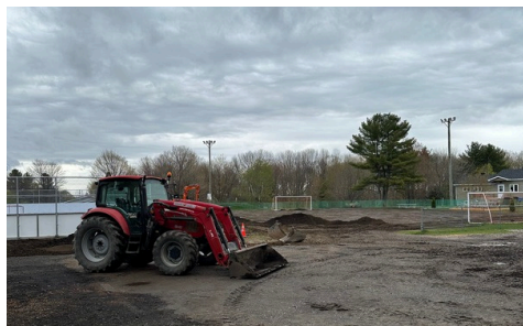
Préparation du terrain de soccer
