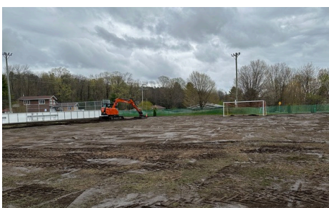
Préparation du terrain de soccer
